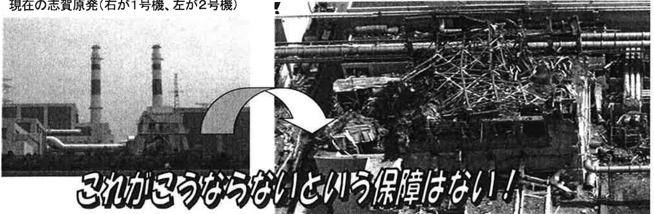
水素爆発で建屋が破壊された福島第一原発3号機
